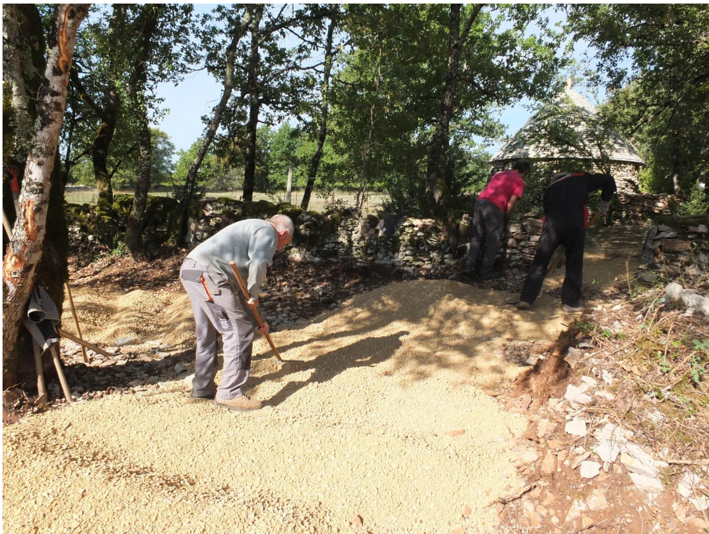
Mise en place de « stérile à faible granulométrie » sur les places de stationnement 2x10 tonnes. (budget mairie)
