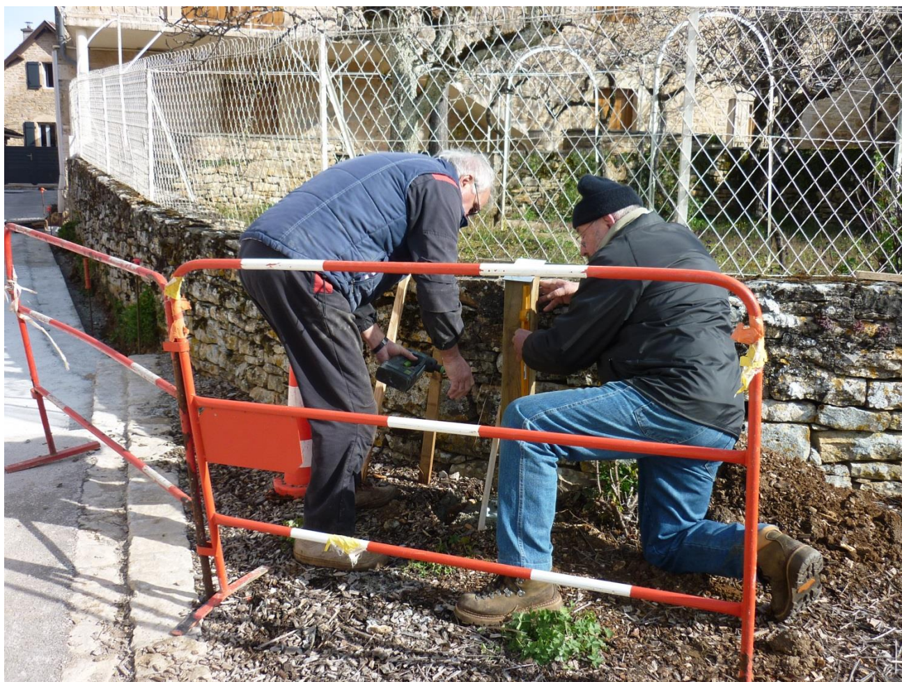
Poteau pour panneau pupitre « Fort de Martiel »
