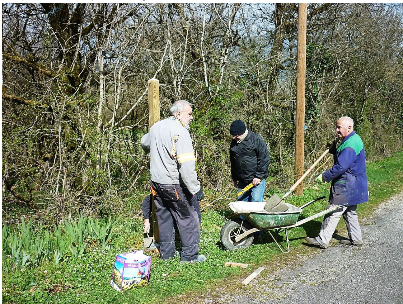
Implantation du poteau départ circuit des Templiers à Ginouilhac
