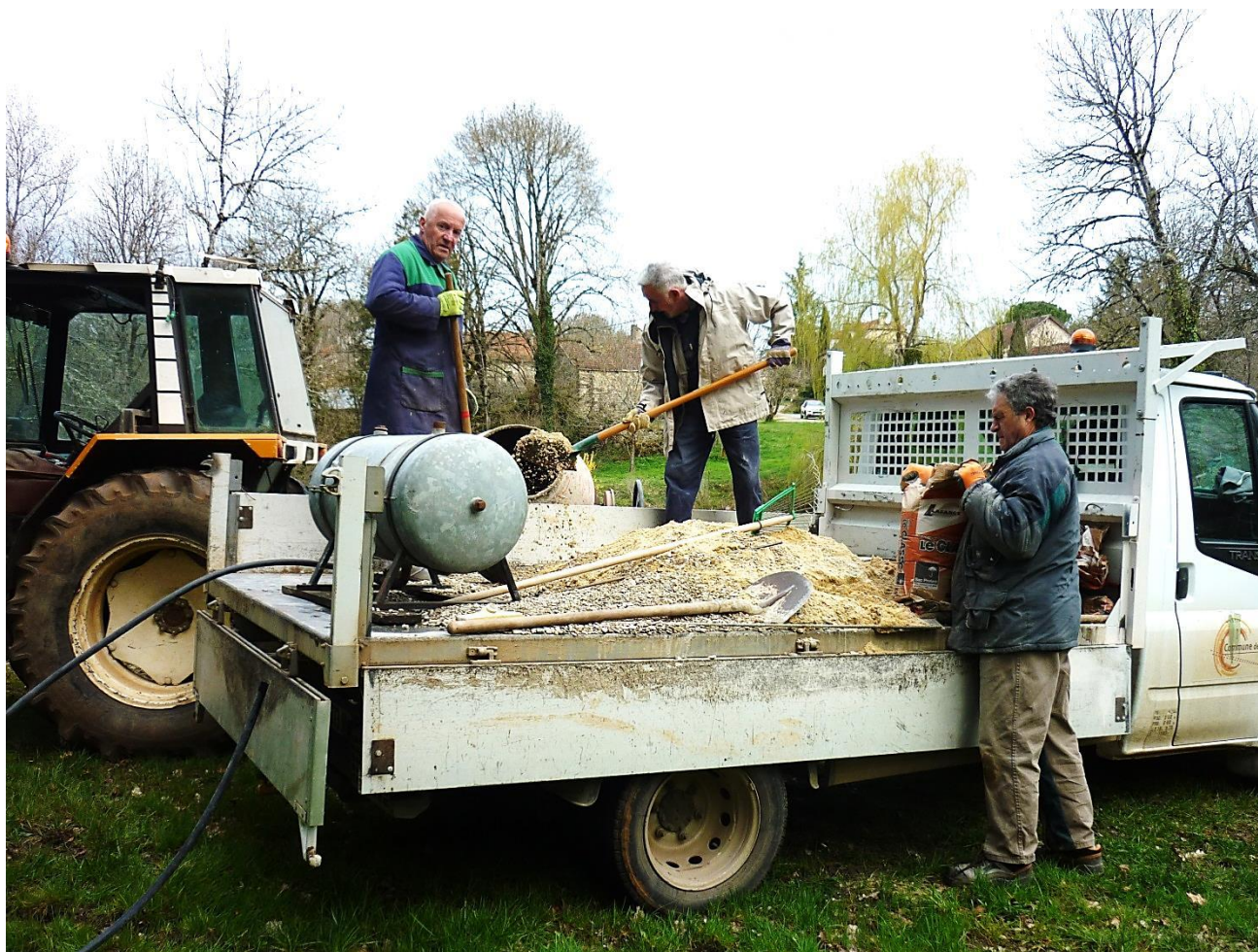
Préparation du béton près de l'étang de Massar
