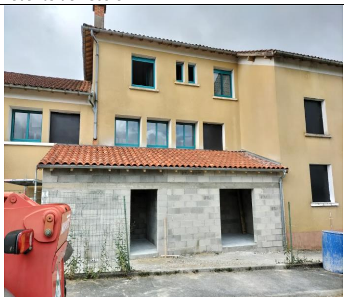
Construction d'un local annexe qui recevra la chaudière à granulé de bois et une trémie de stockage.
