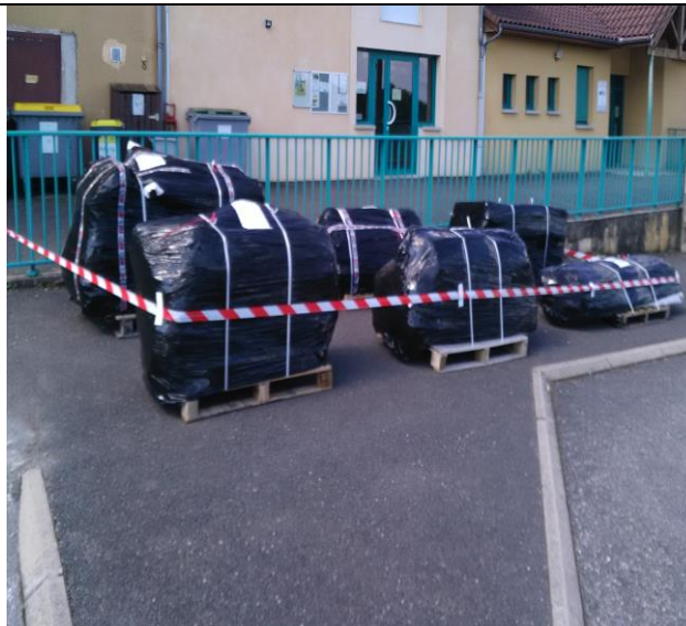
Fenêtres comportant de la peinture au plomb détruites selon le protocole de décontamination et emballées pour être évacuées
