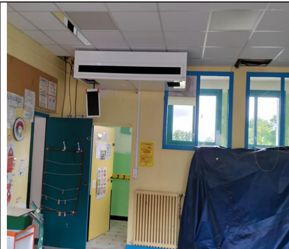
Cassette de renouvellement de l'air en cours d'installation
