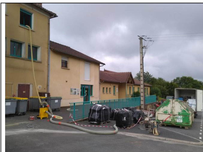
Opération d'aspiration de la laine de verre des combles
