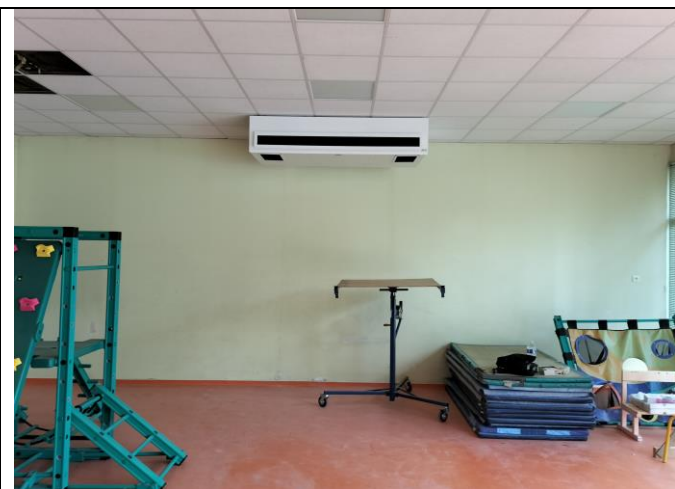
Luminaires à leds (quasi-invisibles dans les salles équipées d'un faux plafond)
