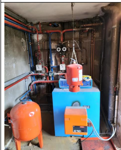
Ancienne chaufferie dont la chaudière à mazout sera déposée
