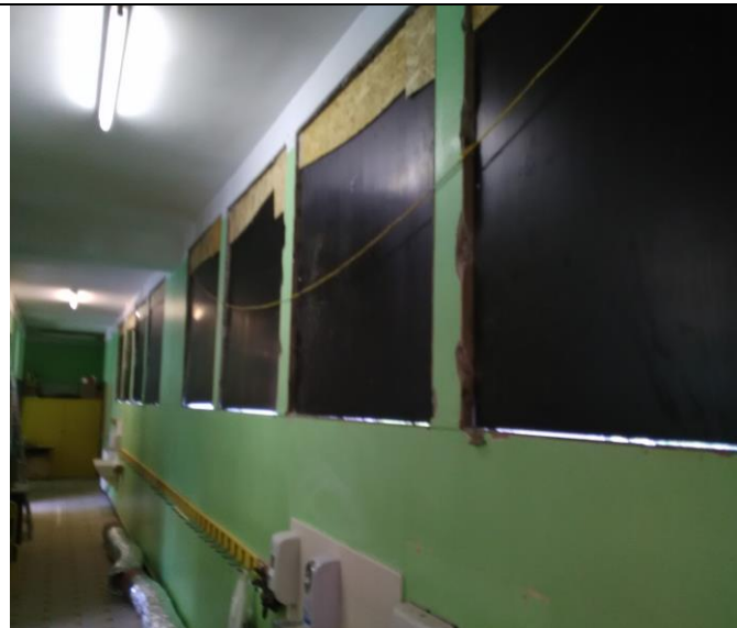
Phase intermédiaire entre la dépose et la repose des fenêtres (couloir du R+1)
