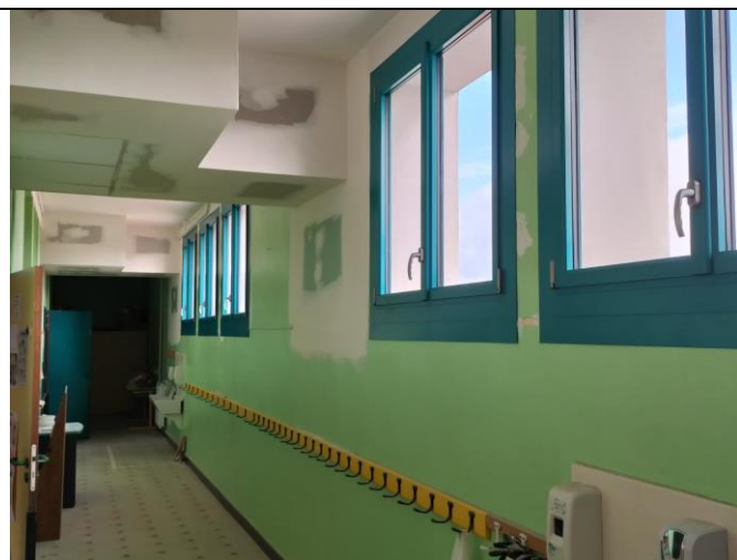
Couloir du R+1 équipé des fenêtres et des caissons contenant les gaines de ventilation
